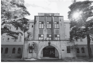
10 旧東北帝国大学工学部機械学及び電気学 教室（現多元物質科学研究所南 1 号館）
