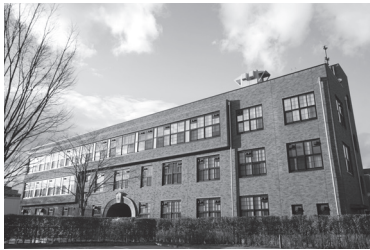
12 旧仙台高等工業学校建築学科棟 （現 21 世紀情報通信研究開発センター）
