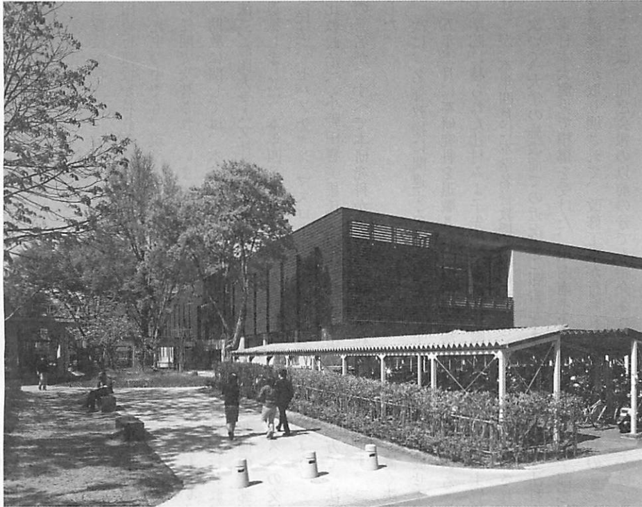
完成した「文科系総合講義棟」(南キャンパス生協側から)
