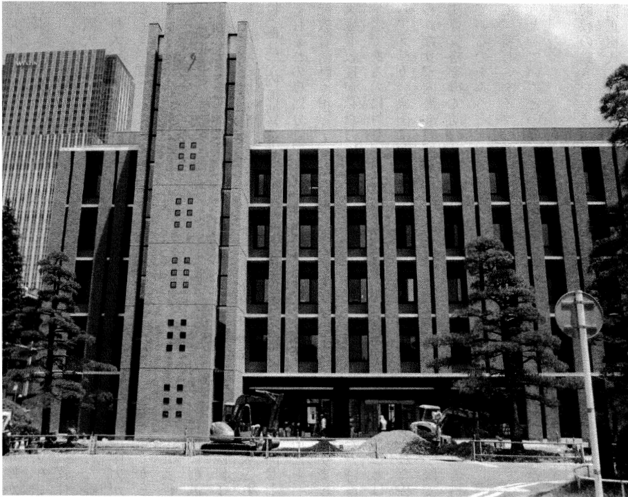
完成間近の「片平エクステンション教育研究棟」
